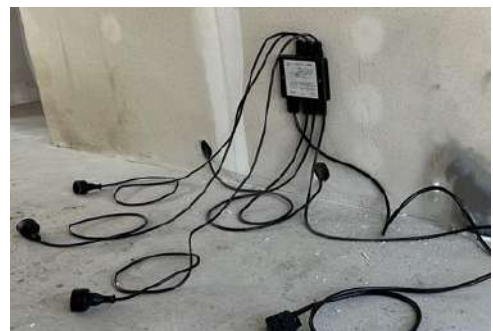
Voorbeeld keukenverdeler met aangesloten kabels
